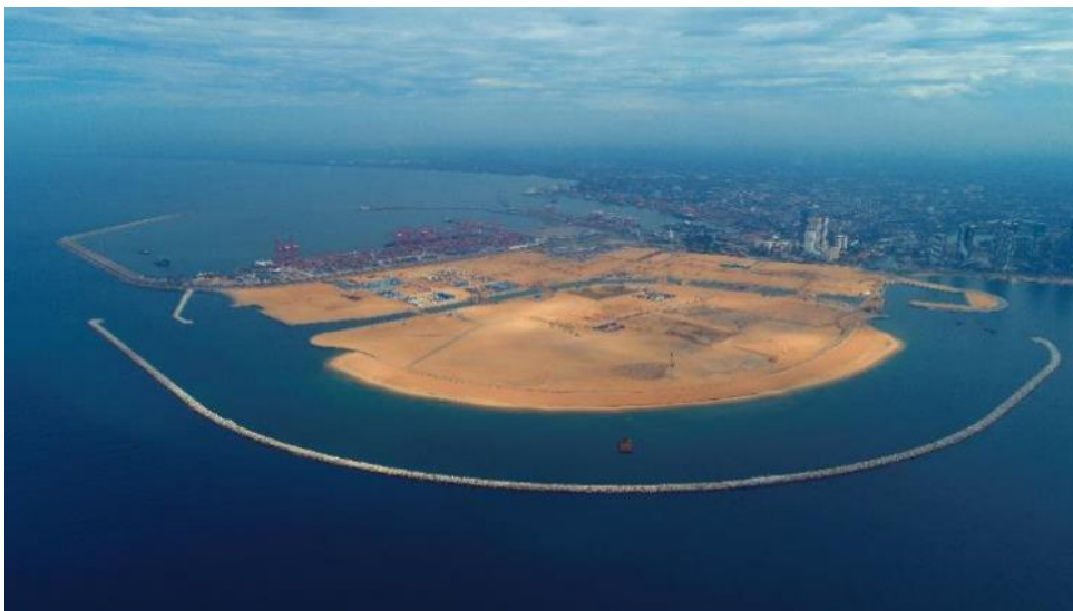
Le polder du Colombo Port City Project
