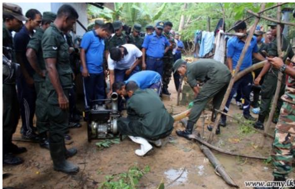
Nettoyage des puits
