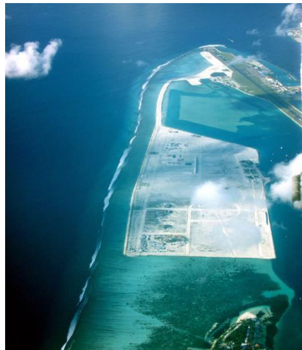
Figure 25 - L'île d'Hulhumalé en construction
